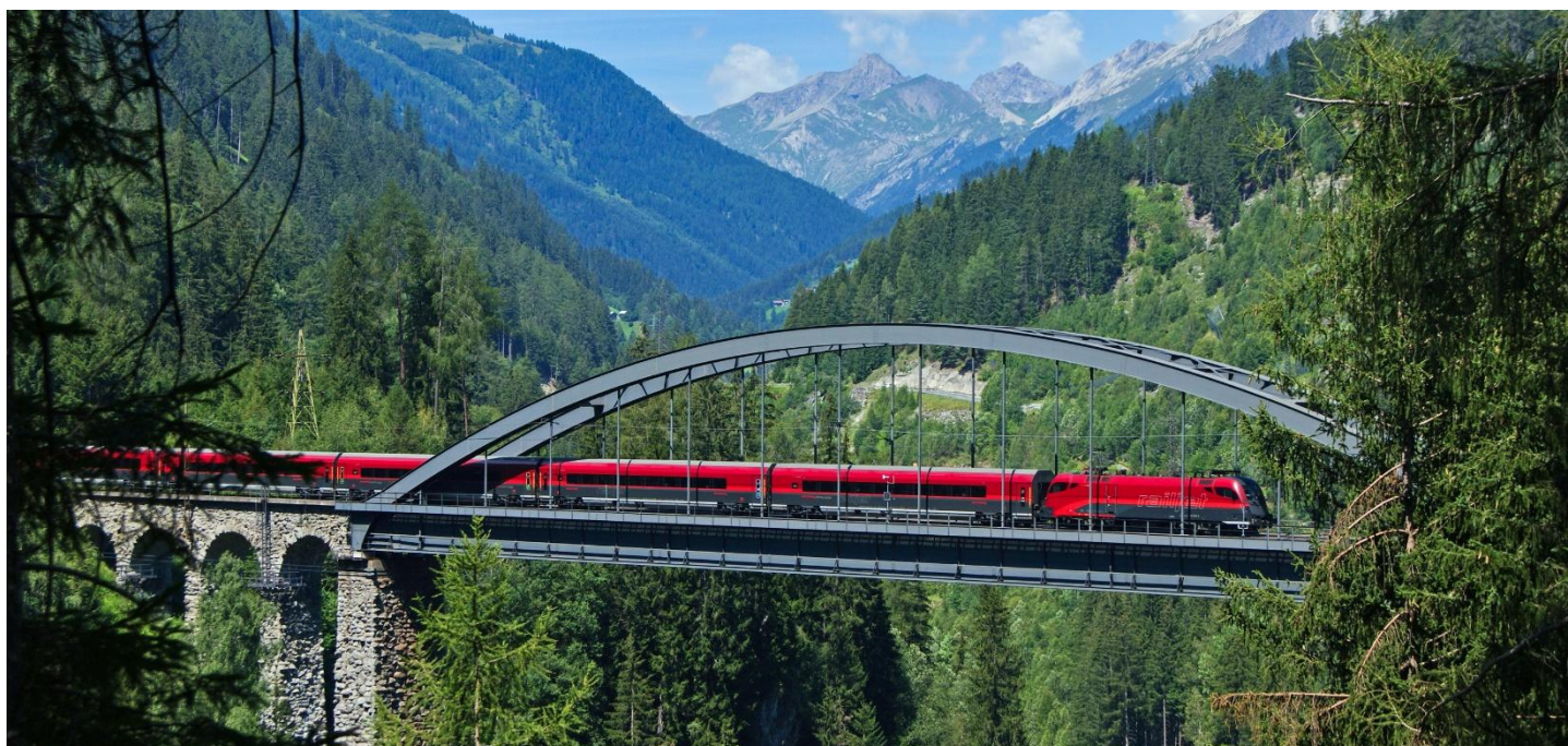
Railjet auf dem Trisannaviadukt (Arlbergbahn)
