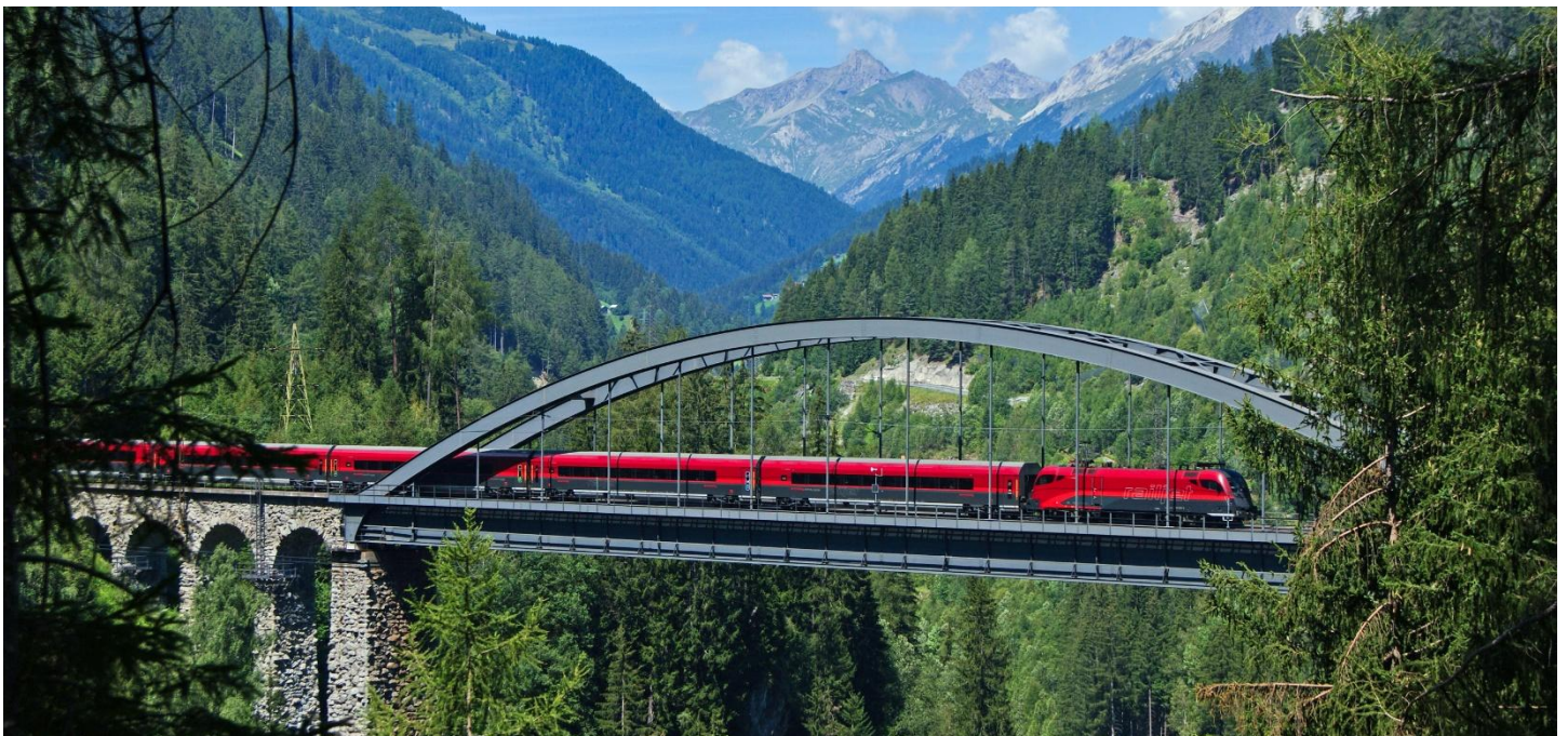
Railjet auf dem Trisannaviadukt (Arlbergbahn)
