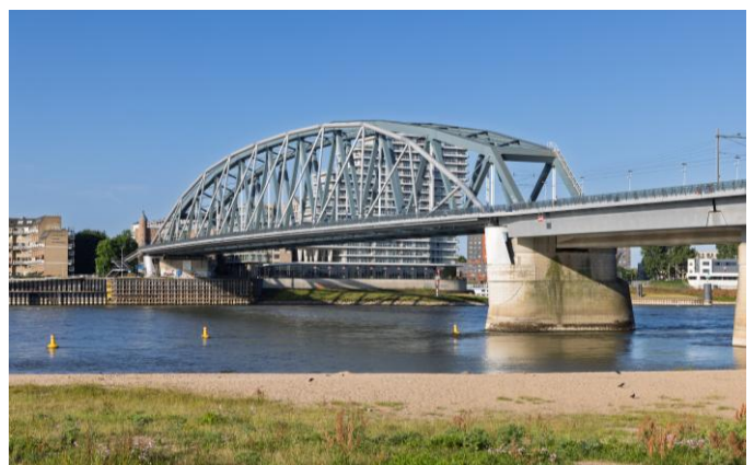
Stahlbrücke bei Nijmegen
