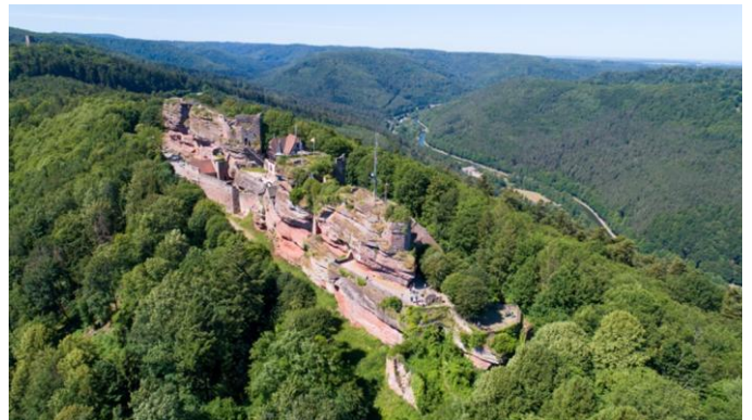
Ruines médiévales de Haut-Barr
