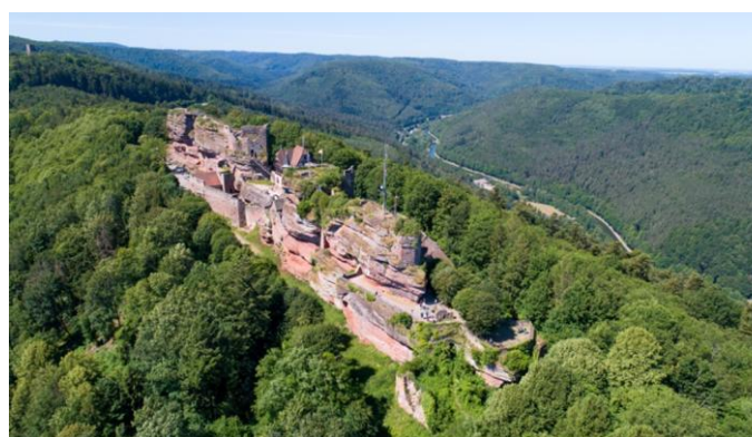
Ruines médiévales de Haut-Barr
