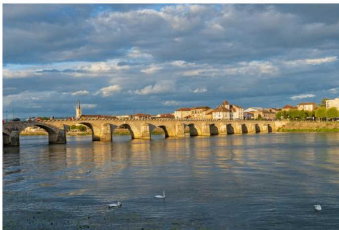
Pont Saint-Laurent à Mâcon
