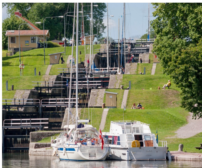
Die Carl-Johan Schleusentreppe
