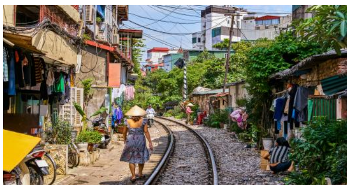
Ligne de chemin de fer à travers le village
