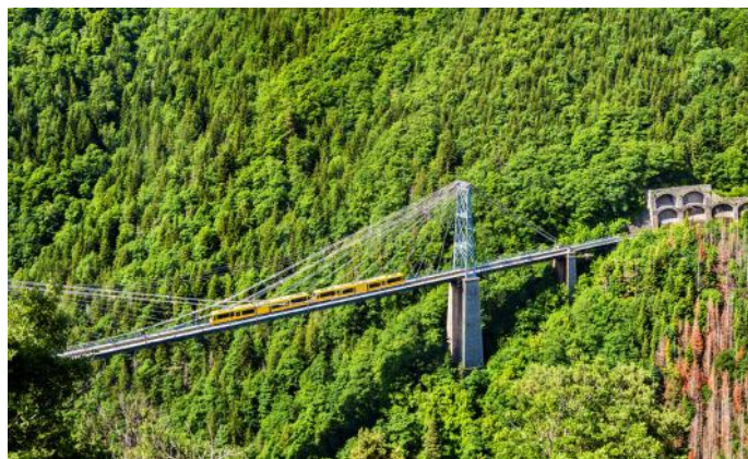
Le "Pont Gisclard" - un pont suspendue
